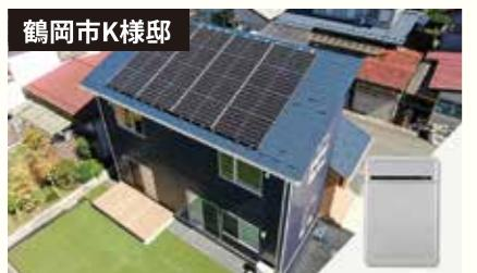
ハンファ Qセルズ太陽光発電5.68kW システム
